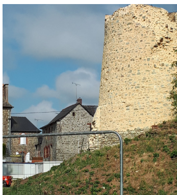
Une tour rénovée
