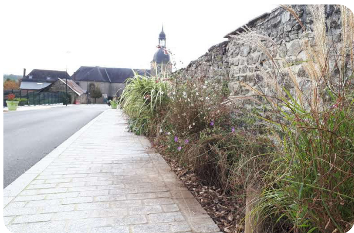
Aménagement de la RD 107
