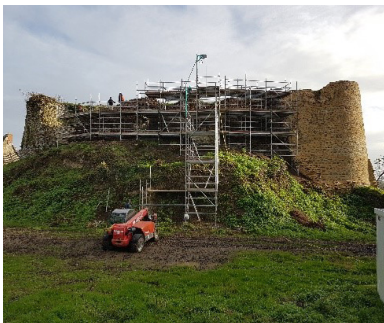
Les travaux du château à l'automne
