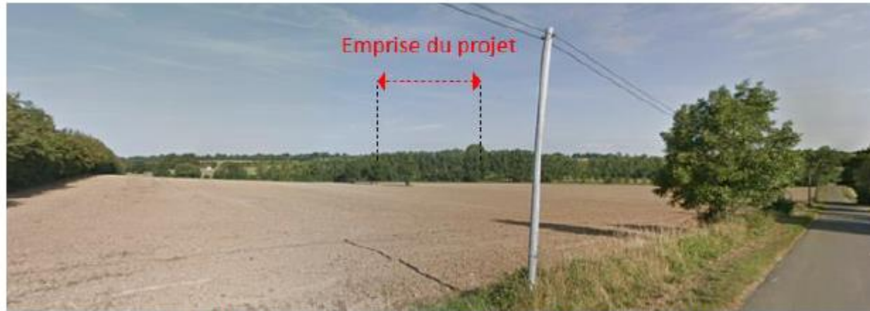
Figure 103 : Vue depuis la D116 au sud-est du site en été - © Google Street View juillet 2018
